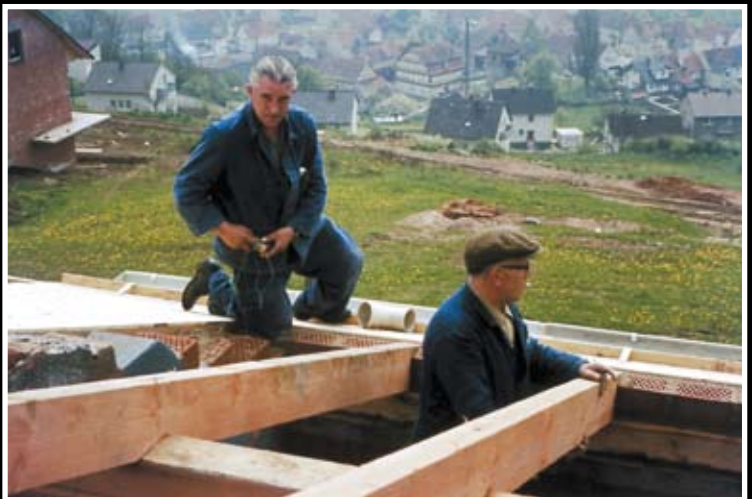
Klempner und Installateur Jakob Becker (Altmorschen) 1970
