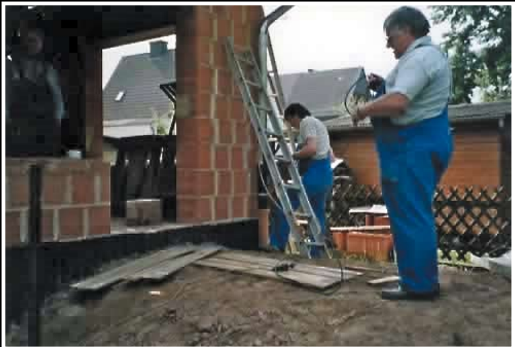
Kurt Becker, Altmorschen (Sanitär- und Heizungsbau)
