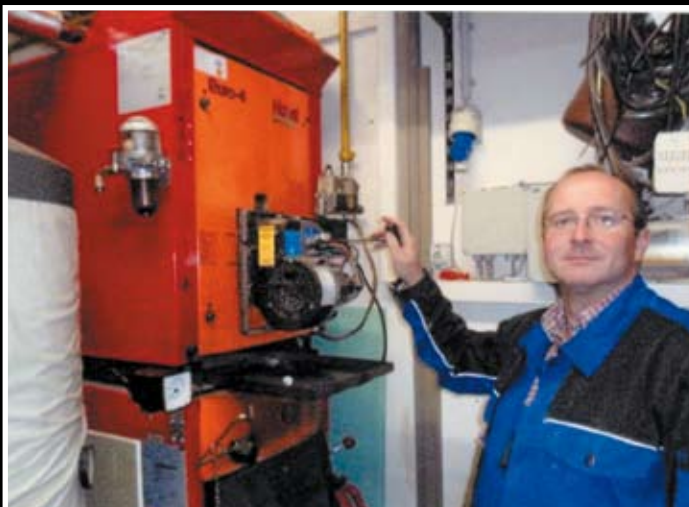
Jens Gipper, (Sanitär- und Heizungsbau) Altmorschen
