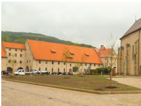
Blick vom Domänenhof auf (von links) Kutscherhaus, Marstall, Klosterscheune und Burggrafenhaus
