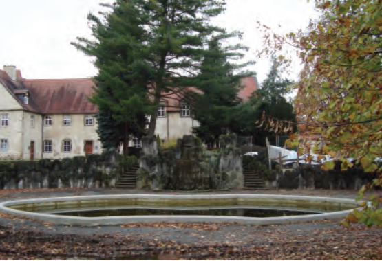
Wasserbassin Untere Südterrasse November 2013
