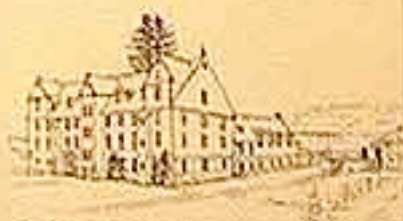
Das Westflügel 1905 nach dem Standschloß des Architekturs Bild
