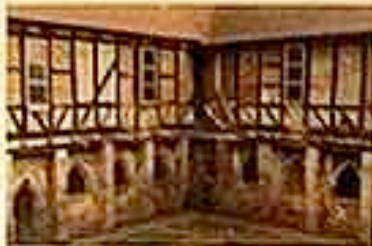
Saal des Kreuzgangs, Zustand 1986
