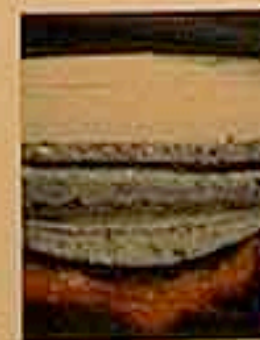
Detailansicht des Putzes an der Decke des Saalbauwerks, 17. Jh., an der Decke
