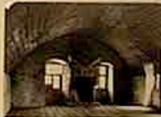
Saal des Kreuzgangs, Zustand 1986
