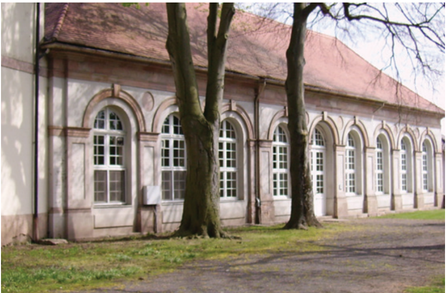
Orangerie Haydau, Bauzustand 2009.
