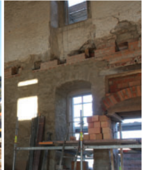
Innenraum Marstall vor Einbau der neuen Decken
