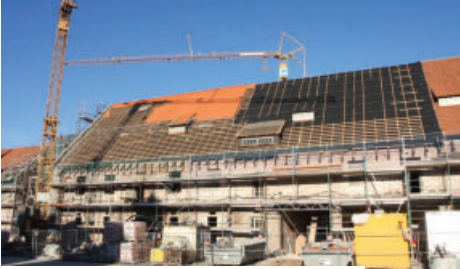
Klosterschene vor der neuen Dachdeckung
