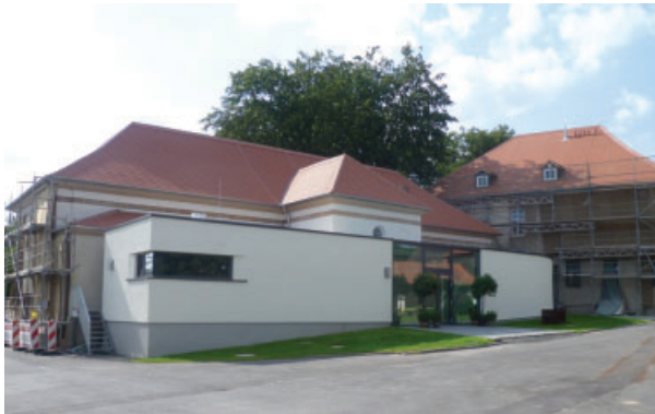
Die neue Rückseite, die auch die neue Eingangsseite ist, im Oktober 2011
