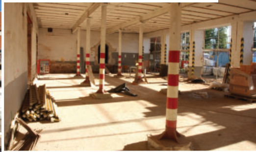
Innenraum ehemalige Gemeindefeuerwehr
