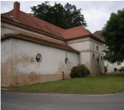
Die Rückseite der Orangerie bis 2009
