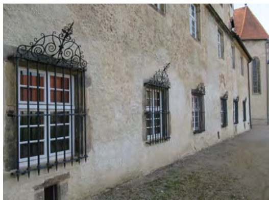
Fenstergitter am Ostflügel von außen
