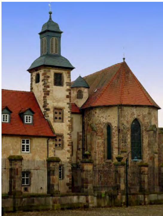
Klosterkirche mit landgräfllichem Glockenturm vor Wiederherstellung des historischen Putzes der Außenfassade 2013
